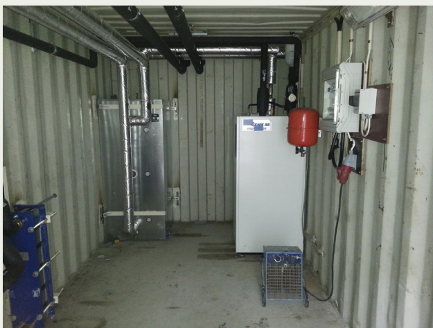
Figur 2. Bilden visar värmepumpen (till höger i bild) och ackumulatortanken. Dessutom ser man till framför värmepumpen ett värmelement på 9 kW.
